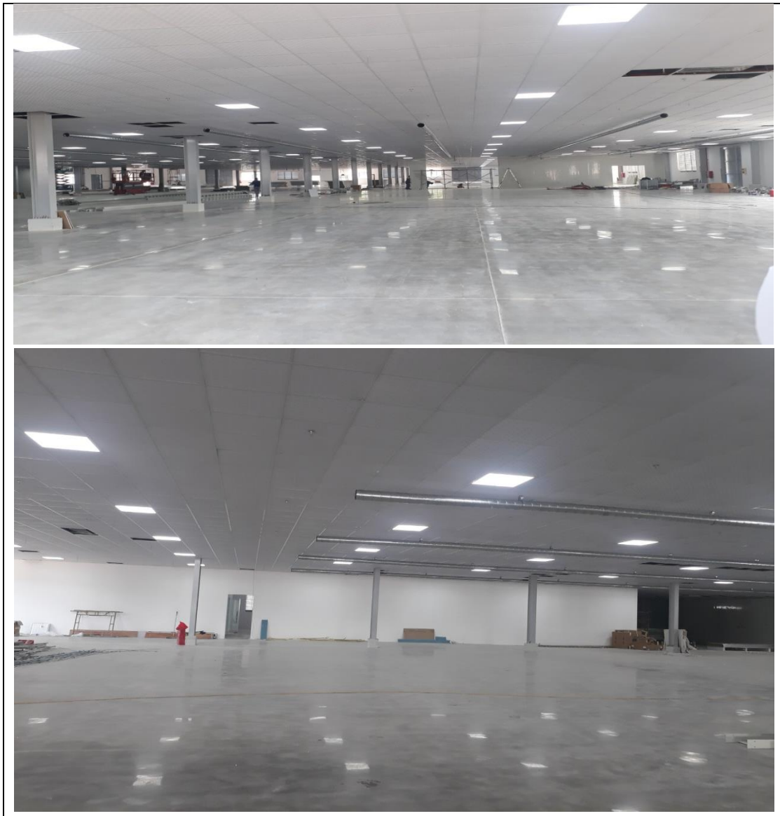
Hình 1. 8. Hiện trạng khu đất xây dựng
